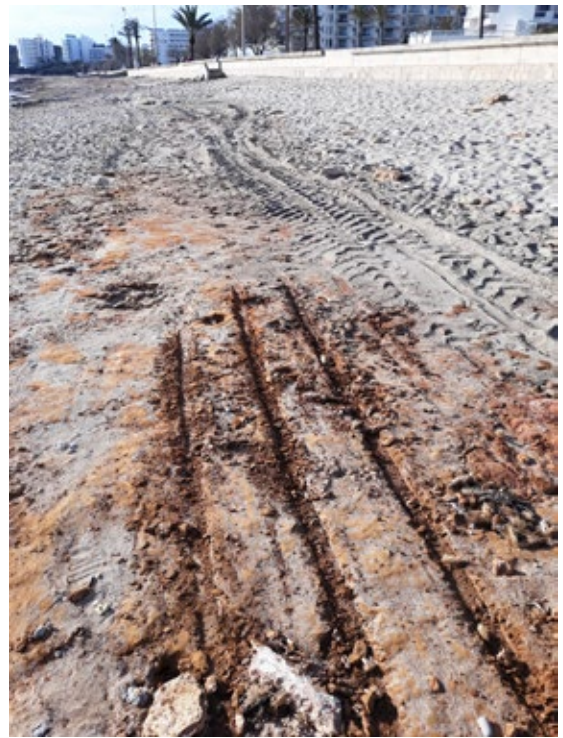
Figura 5. Exemple d'erosió de la platja de Cala Millor produït per la retirada d'arena durant el temporal Glòria (2020), deixant a la vista el paleosol del Pleistocè. La imatge mostra marques d'utilització de maquinària pesant. FONT: Vicens et al. 22
